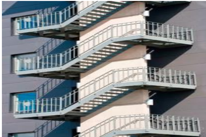
3.22 – rasm. Ko‘p qavatli binoning tashqi yong‘in qochish yo‘lagi 35 .
