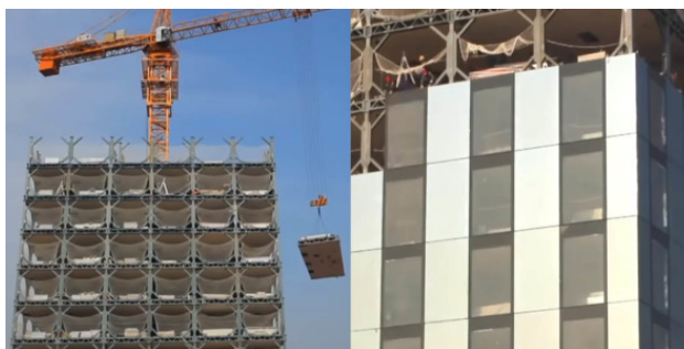
Сборка модульных компонентов здания © Кадры из видео Broad Group
