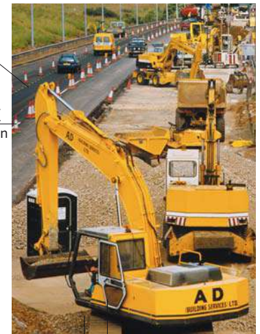
重铺路面 zhòngpū lùmiàn resurfacing
