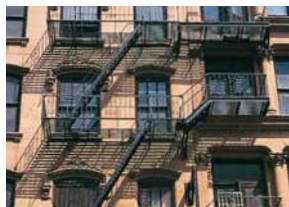
消防通道 xiāofángtōngdào fire escape
