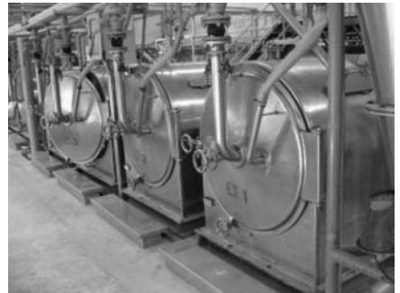
(d) Horizontal extractor
